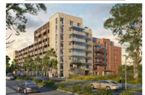
HYRESRÄTTER. I fastigheten Lokstallet byggs 72 hyresrätter, de första i HSB:s regi på över 30 år.
